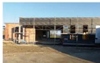
Travaux Crèche / Déc. 2015
